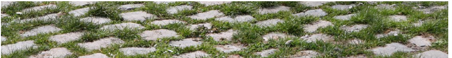
De trambedding wordt aangelegd in kasseien met een groene voeg
