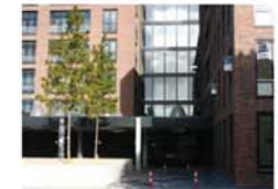
Uit de windtunnel bleek windhinder mogelijk bij de entree van de Holland in Tilburg, waarna een luifel werd ingepast.
