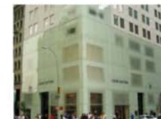
De plint verschilt in verschijningsvorm van de rest van de toren. De onderste lagen reageren op het stedelijk leven op straatniveau.
