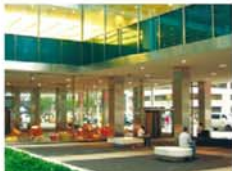
De benedenverdieping van het Lever House is bijna transparant; je kijkt er van de patio op de straat.
