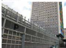
De achterkant van Westpoint wordt gedomineerd door een parkeergarage op het maaiveld.
