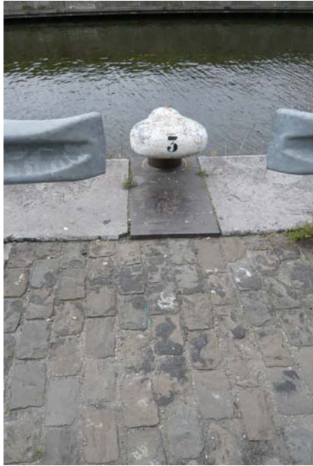
KADE ALS MONUMENT doorlopende boordsteen in Belgisch hardsteen, duurzaam materiaalgebruik
