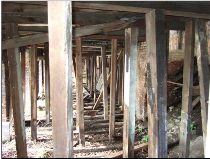
Foto 7: Het dek tussen de gewelven wordt volledig door houten balken gestut
