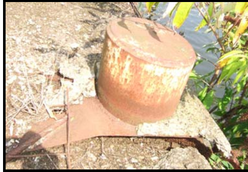
Foto 3: Bolder met opgelaste ankerstaven
