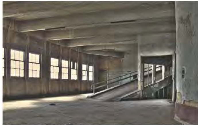
Hellingbaan van niveau +3 naar niveau +4
