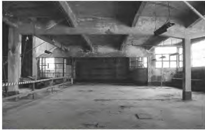
Hellingbaan van niveau +3 naar niveau +4
