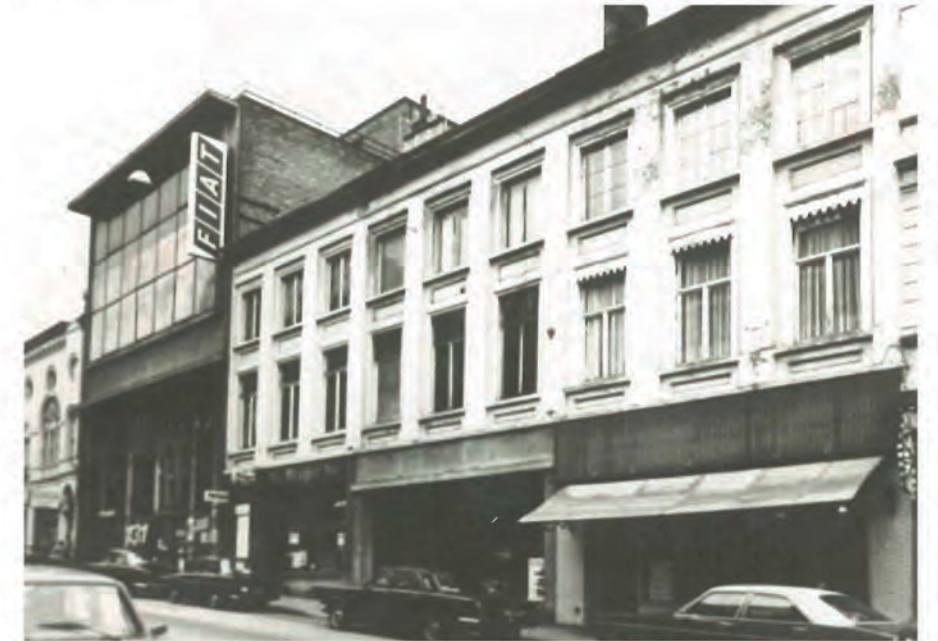
Gevel van de Lammerstraat met verhoogde facade. Fiat concessie tot 1978
