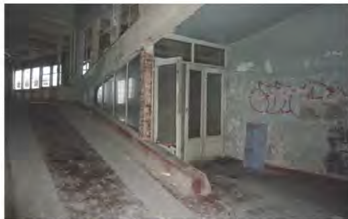
Hellingbaan van niveau +3 naar niveau +4
