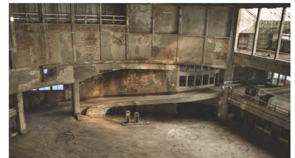
Huidige toestand, hellingbaan van niveau +1 naar niveau +2
