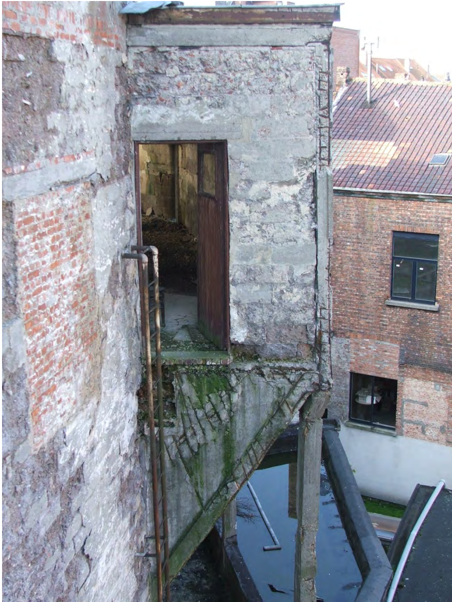
Instandhoudingswerken: betonherstellingen
