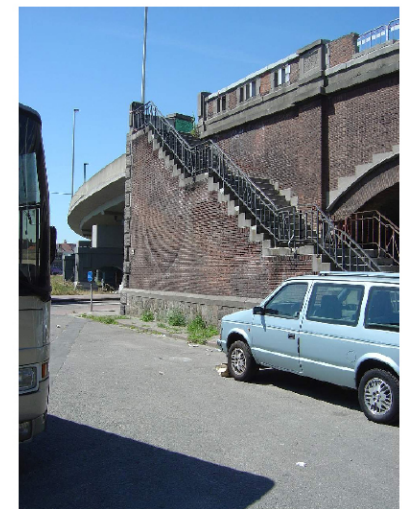
trappen naar het Noorderlaan viaduct
