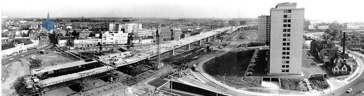
Foto's van de bouwcampagne laten een immense kaalslag zien die de continuïteit van de steenweg verbreekt en de actuele ruimtelijke structuur tot stand brengt. De infrastructurele en architecturale schaalvergroting is enorm.
