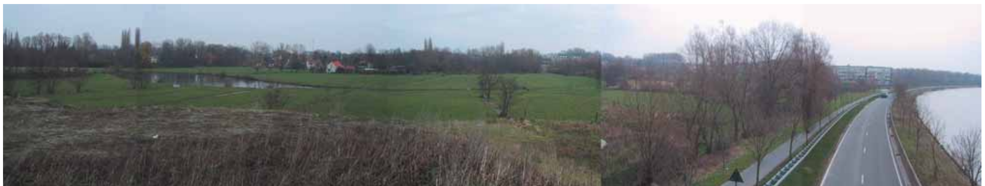
Deelproject 'verbindingsweg R4-stationsomgeving', zicht vanop de brug over de ringvaart naar de stationsomgeving. (opname 2003) Synthesedocument
