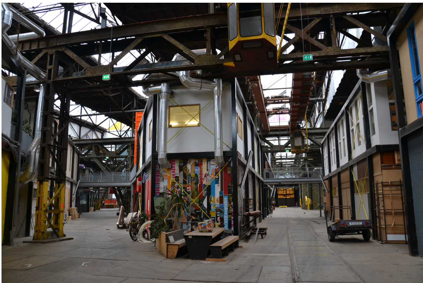
NDSM werf, Amsterdam: productiebroedplaats voor kunstenaars. Enkel de staalstructuur + circulatie en technieken werden voorzien zodat kunstenaars hun eigen atelier (naar eigen goeddunken maar vooral goedkoop) konden afwerken. Bottem Up initiatief dat opgepikt werd door het beleid.
