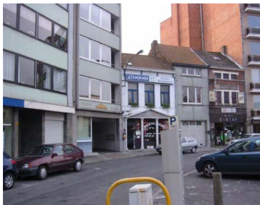
Zicht van Colinetplein naar de doorsteek naar het park Schelfhout
