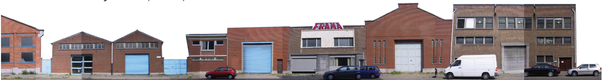
Kattendijkdok-Oostkaai oostelijk deel ( Zuid )
