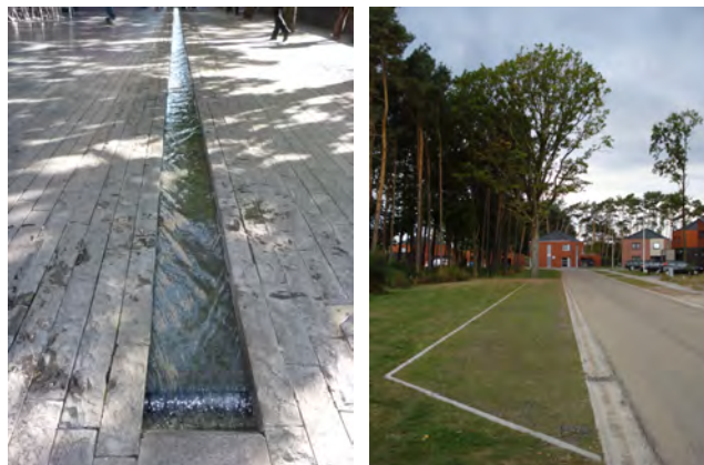
referentie woonerven: afvoer regenwater in open lucht en parkeerstroken in halfverharding
