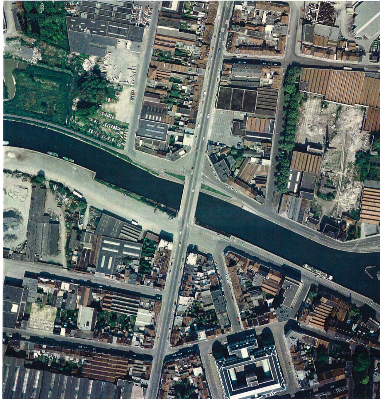
Gerechthofbrug: bestaande toestand 15.05.88 (Eurosense)
