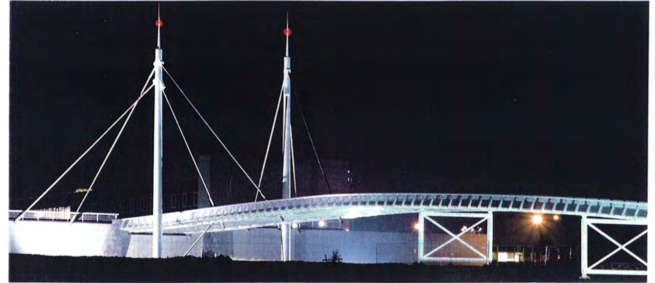
Tuikabelbrug te Feluy (Petrofina) →
