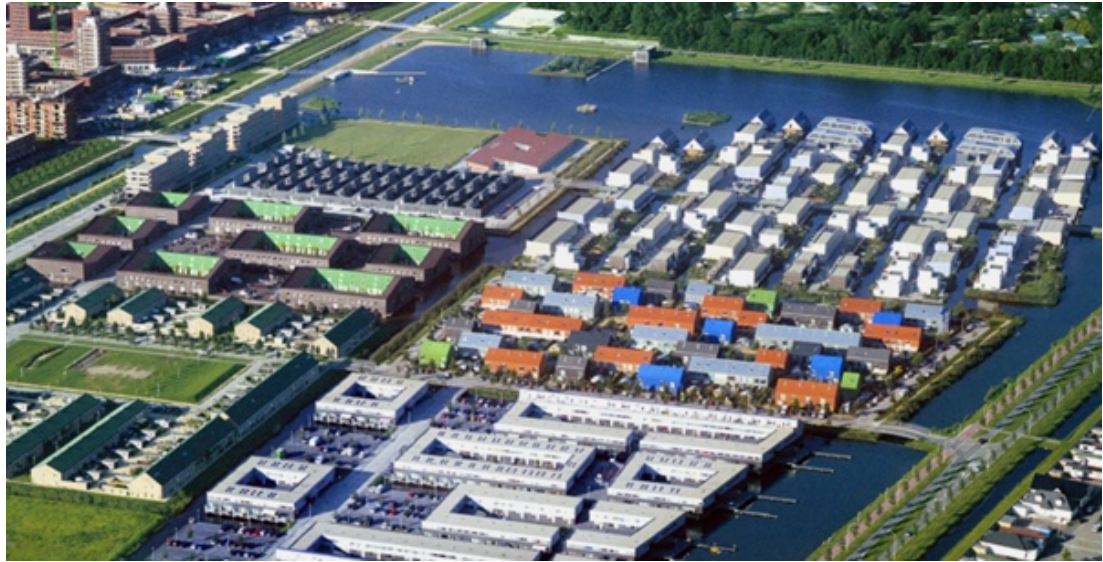
Ypenburg, MVRDV, Den Haag - Eenduidige korrel en volumetrie
